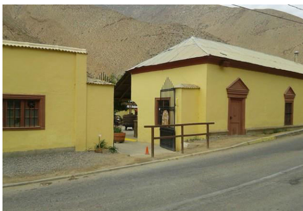
Façade Pisco Los Nichos.
