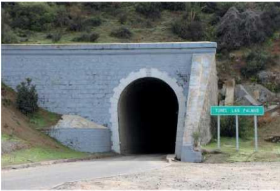
Tunnel Las Palmas-El Quelón. Foto: Stadtverwaltung Los Vilos.
