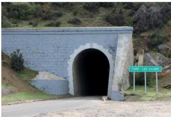
Tunnel Las Palmas-El Quelón. Photo Mairie Los Vilos.
