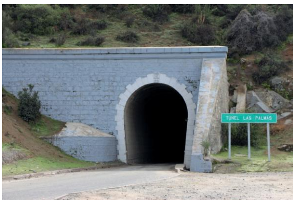
Túnel Las Palmas-El Quelón. Foto Municipalidad Los Vilos.
